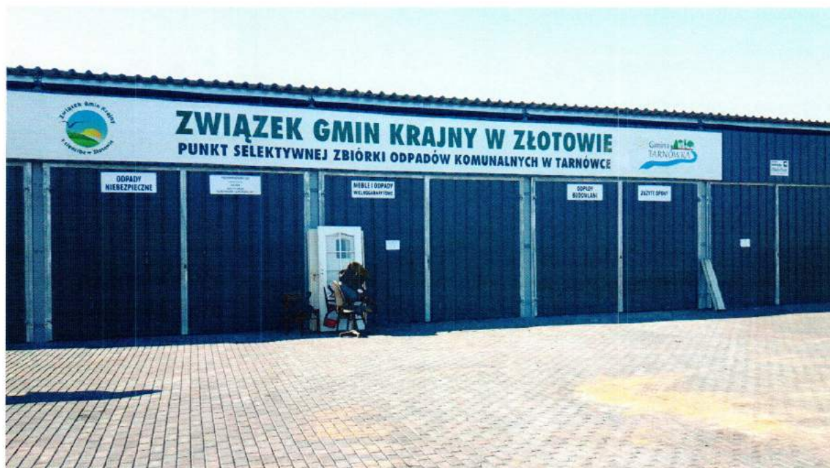
Zdjęcie 3. Punkt Selektywnej Zbiórki Odpadów Komunalnych w Gminie Tarnówka
